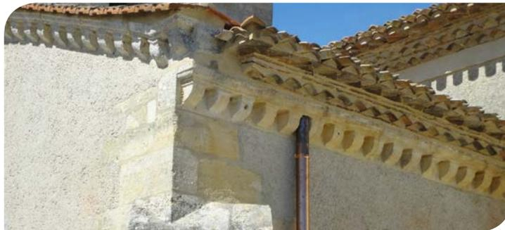
▲ Double rang de génoise partie haute, simple partie basse, jusqu'à la tuile d'égout réalisé avec de la chaux et du sable. Chéneaux blanchon cachés et descente d'eau en cuivre
