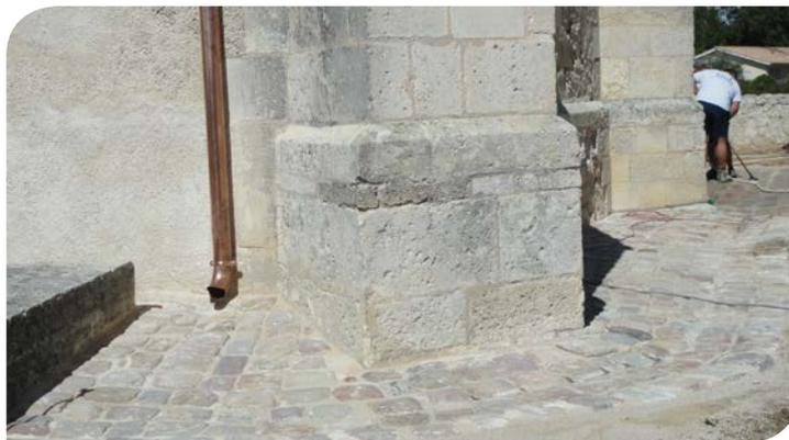
▲ Pose de pavés à l'ancienne, sable et chaux. Le soubassement est repiqué à la chaux, avec une truelle, ceci pour sortir l'humidité afin d'assécher les murs
