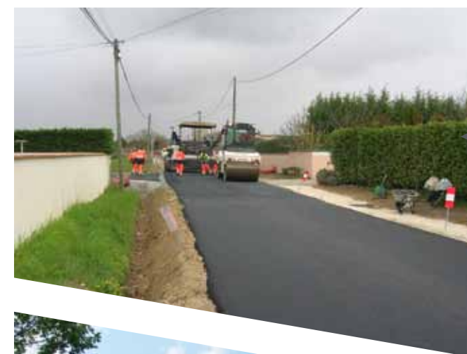
La liaison Saint Sulpice Montussan fait peau neuve mais reste néanmoins limitée à 50 km/h Ici mise en oeuvre de l'enrobé avant pose des signalisations horizontale et verticale
