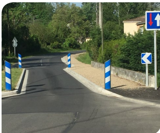
▲ Aménagement d'une écluse et de trottoirs avenue Lagraulta
