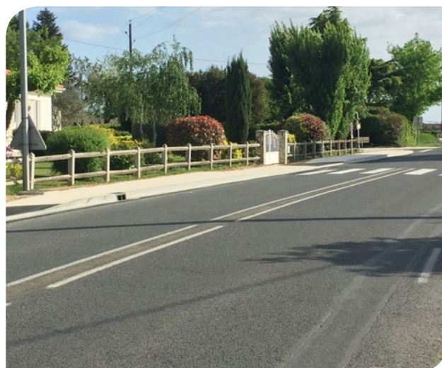
▲ Mise en sécurité de la RD 13 à Cameyrac
