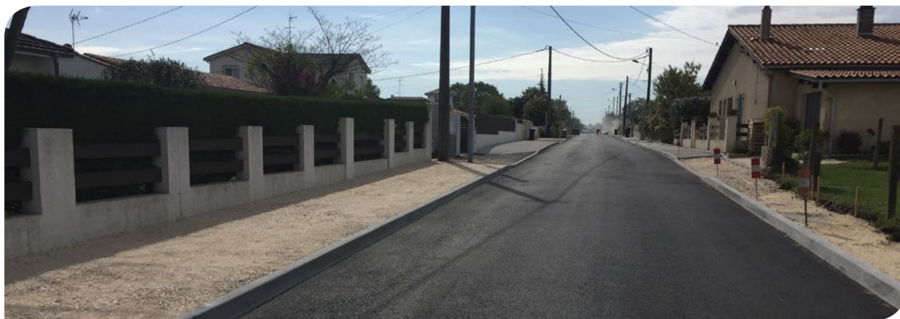
▲ Aménagements de trottoirs, réfection de la chaussée et des bas-côtés Allée de la Pépinière
